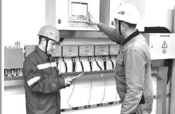
В рамках планово-предупредительного ремонта энергоблока № 4 Ростовской АЭС (филиал Концерна "Росэнергоатом", Электроэнергетический дивизион Госкорпорации "Росатом") на резервную дизельную электростанцию (РДЭС) установлены датчики контроля температуры подшипников и охлаждающей воды цилиндров. При работающем дизель-генераторе информация с датчиков в режиме реального времени теперь поступает на пункт контроля, что позволяет более детально отслеживать техническое состояние РДЭС.
